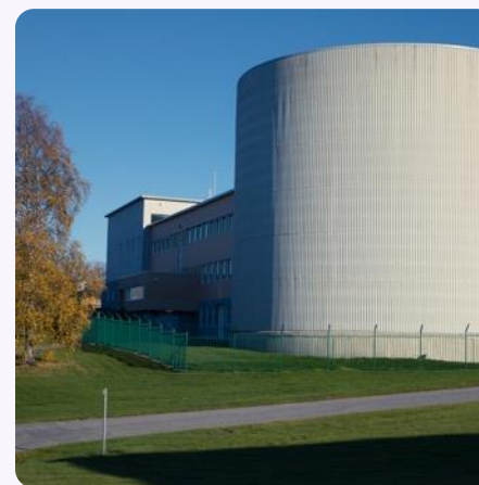
Anleggene på Kjeller Overføres NND Q3 2028 Konsesjon til 31.12.28
