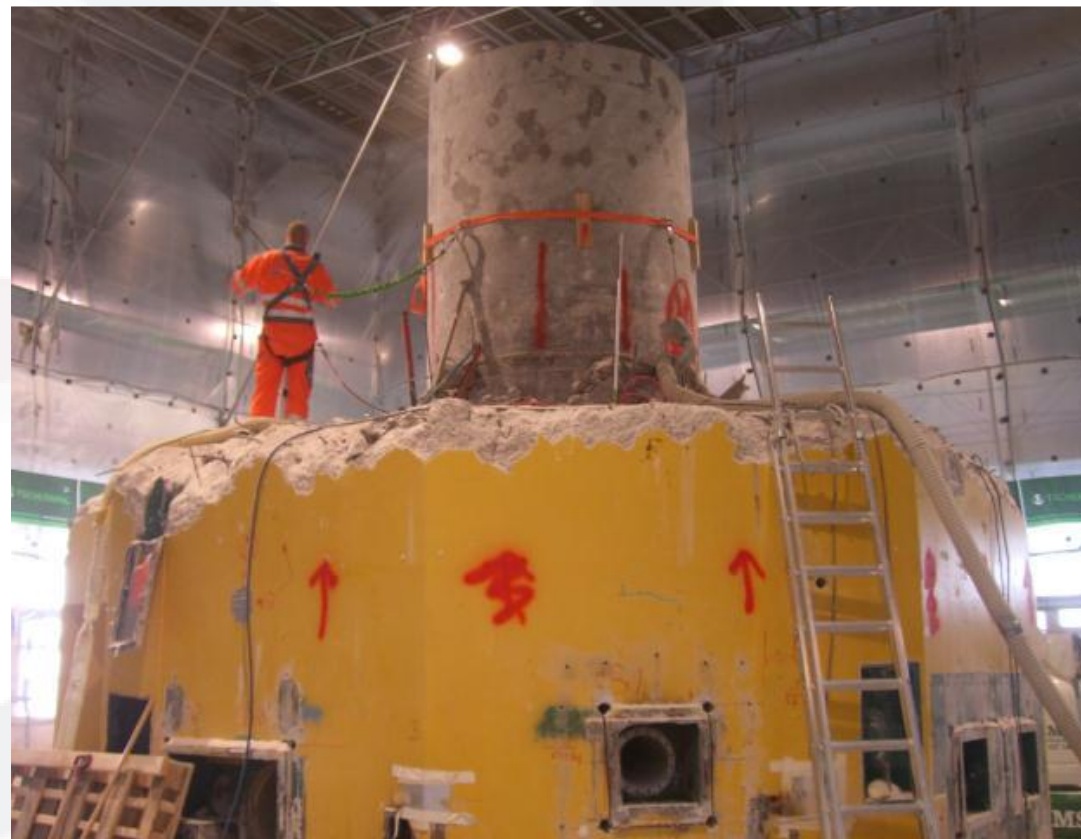
Rivning av forskningsreaktoren DR2 ved Risø, Danmark (Foto: Dansk Dekommissionering)
